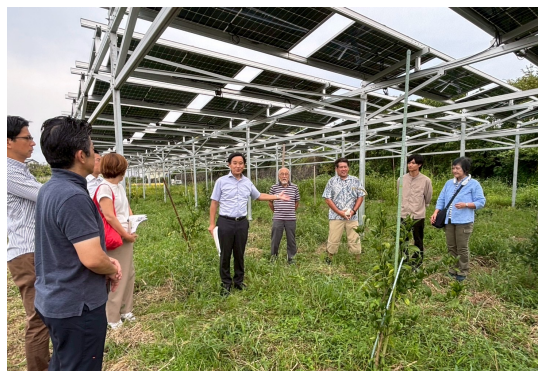
矢作の里 ソーラーシェアリング (5号機)
